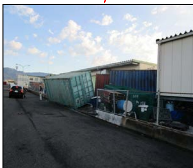
コンテナの倒壊
