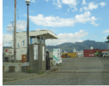
L1: 浸水の痕跡はあまり見られなかった。清掃作業と荷役業務を同時並行で実施していた。
